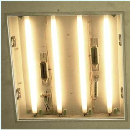
➤ **8** Für vier T8-Leuchtstofflampen, Leistungsstufe 18 W, genügen zwei Vorschaltgeräte und ein Kondensator
