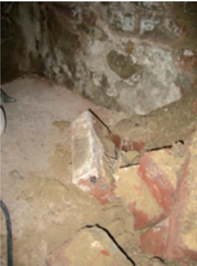
*Das Strangmyzel wuchs bis in die Mauer hinein (hier auf vorsichtig herausgeschlagenen Ziegeln der inneren Steinschicht zu sehen)*
