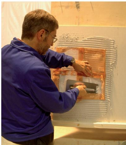
Einbetten von feindrätigem Kupfergewebe in einer dünnen Putzschicht
